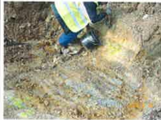
Figure 4 : Tests fond de fouille
