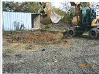
Figure 3 : Excavation de la zone
