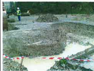
Figure 7 : Tests fond de fouille
