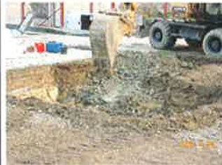
Figure 6 : Excavation de la zone
